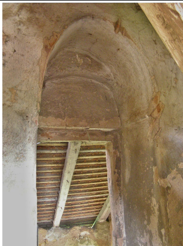
Nika severního vstupu do 1. patra věže v pohledu od jihozápadu z interiéru věže. Foto: Jaroslav Skopec 2012.
