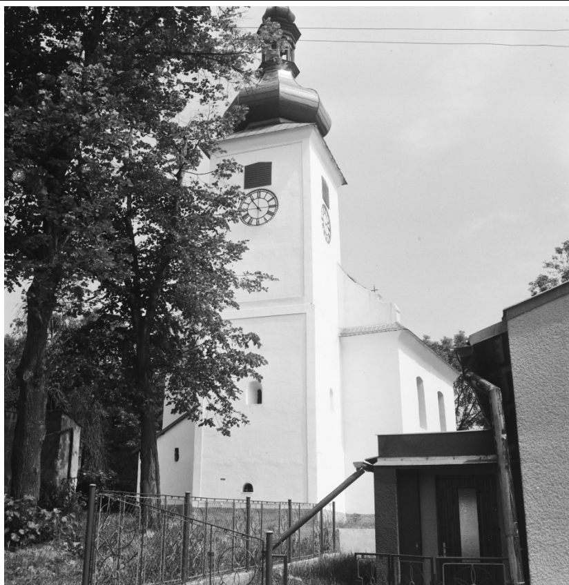
Celkový pohled od západu. Foto: 1976, sbírka negativů NPÚ ÚOP v Ústí n. L., sign. 56456.
