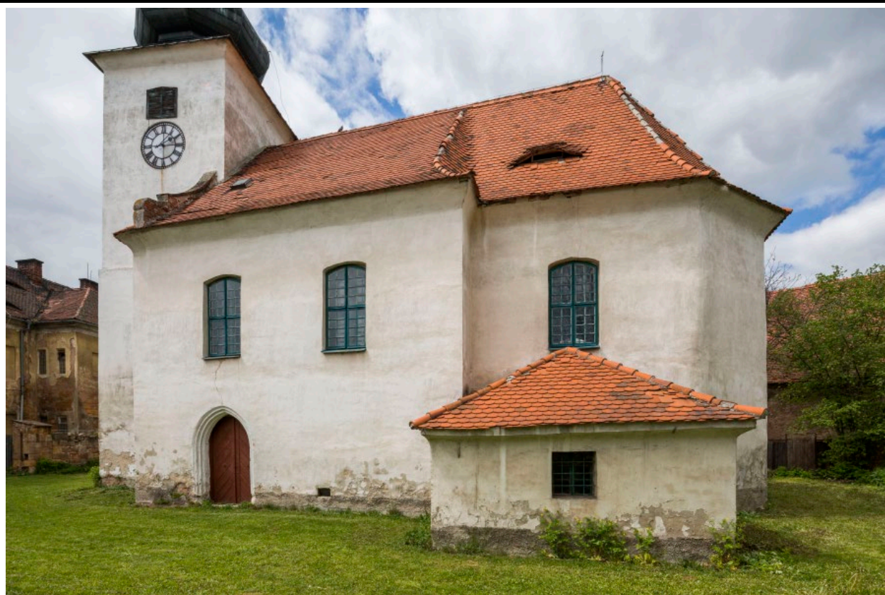
Celkový pohled od jihovýchodu. Foto: Marta Pavlíková 2019.
