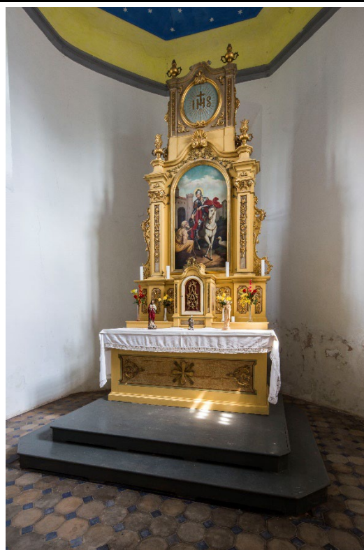
Závěr presbytáře s hlavním oltářem v pohledu od jihozápadu. Vpravo se nachází prasklina v jihovýchodním poli naznačující zardžený hrotitý okenní otvor. Foto: Marta Pavlíková 2019.
