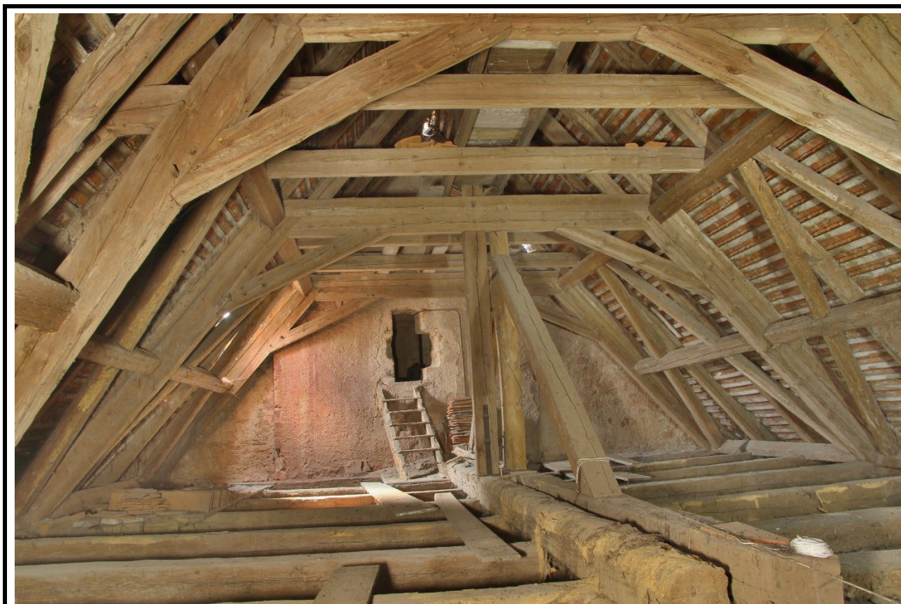
Krov nad lodí v pohledu od východu. Foto: Jaroslav Skopec 2018.
