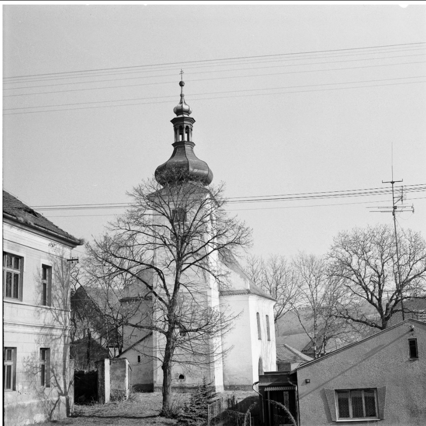
Celkový pohled od západu. Foto: 1988, sbírka negativů NPÚ ÚOP v Ústí n. L., sign. 95704.
